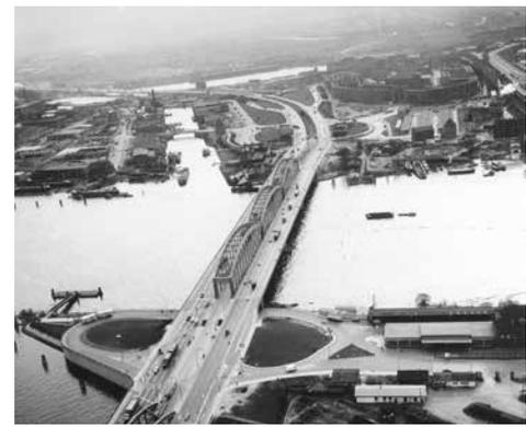
*Eine Nahaufnahme von 1961: Der Verkehr hält sich noch in Grenzen. Gut zu erkennen sind die nach dem Vorbild der Eisenbahnbrücke gestalteten linsenförmigen Tragwerke. An der Zweibrückenstraße (rechts unten) liegt ein Zollamt.*
