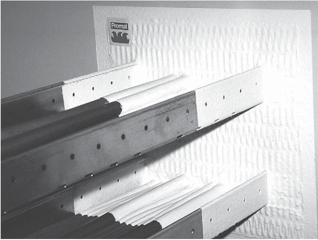
**Bild 3.5** Mineralfaserplattenschott (Weichschott)
