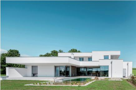
Abb. 33: Ebene Baugrundstücke sind in der Regel unproblematisch. Dieses Haus wurde mit Hanfdämmplatten gedämmt und verputzt. Bildquelle: Synthesa / Capatect.at
