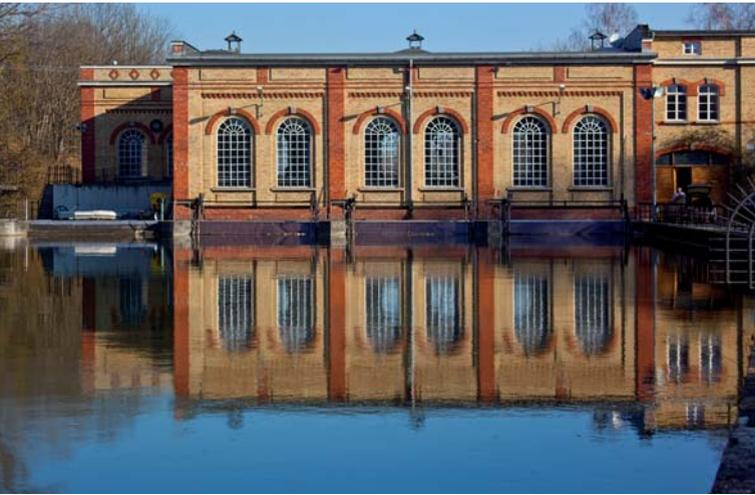
*1902 ging kurz vor der Mündung der Wertach in den Lech das Wasserkraftwerk auf der Wolfzahnau in Betrieb. Seine Turbinen treibt der Vereinigte Stadt- und Proviantbach an, der das Wasser aller Augsburger Lechkanäle aufnimmt.*
